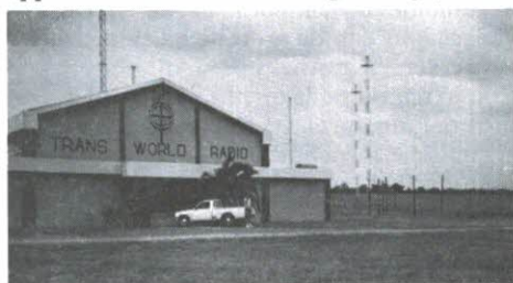
Gertjan 3D6CW buiten zendergebouw. Op de achtergrond de gordijnantenne (rode masten). Ook zijn enkele van de logperiodische antennes te zien.
