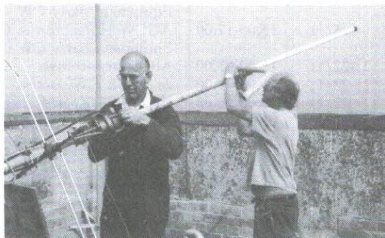
Binnen de veilige muur is het montagewerk aan de gang.
