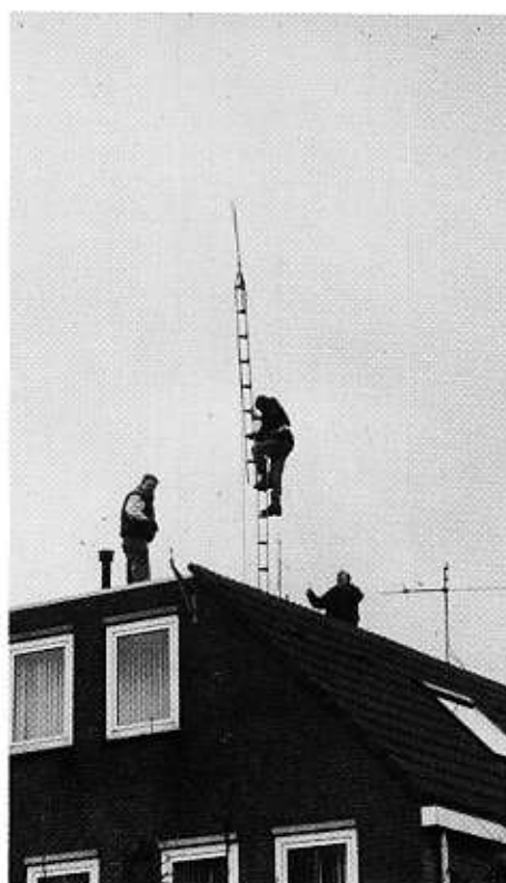
John/PDoHFL in de mast van PI2FLD, Cor heeft duidelijk de touwtjes in handen en Dick koude handen.
