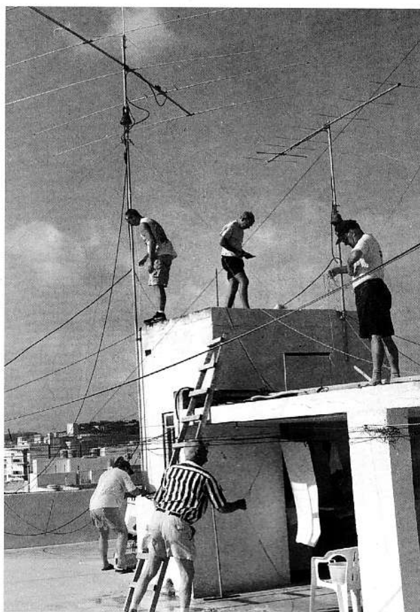
Hard werken aan het fatsoeneren van de tuidraden en rotorkabels. Waar vind je overigens zo'n dak?
