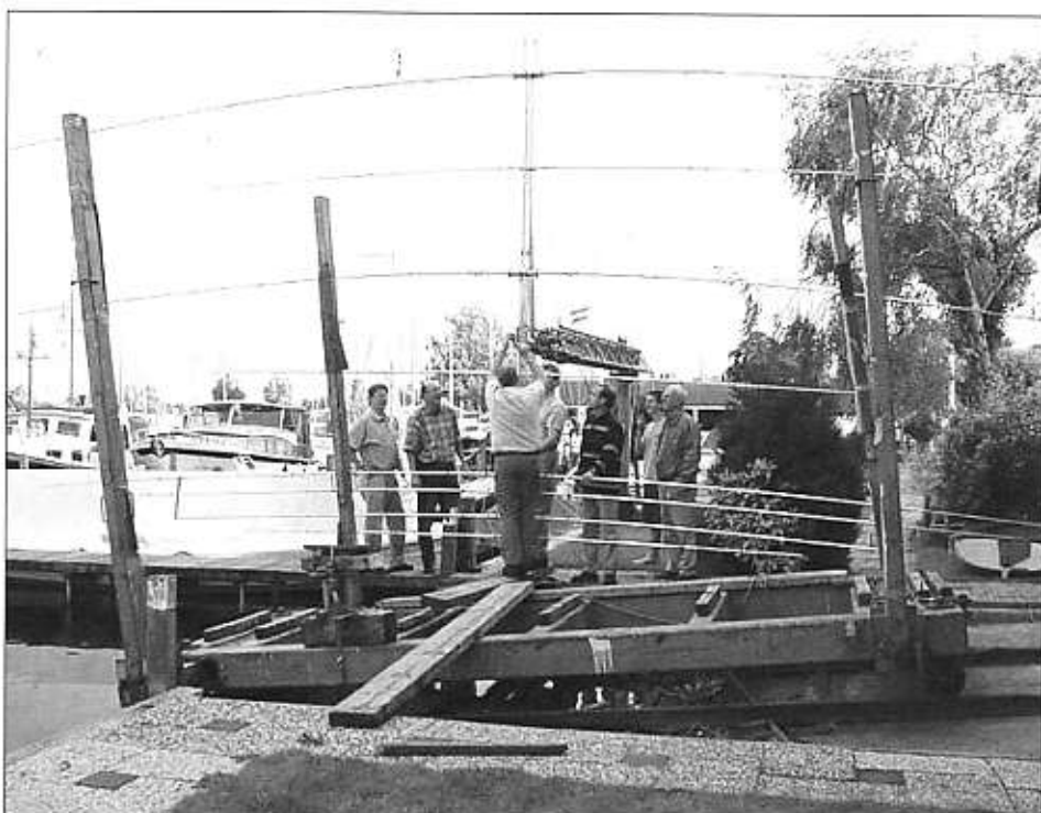
Montage op de mast. Vele handen maken....
