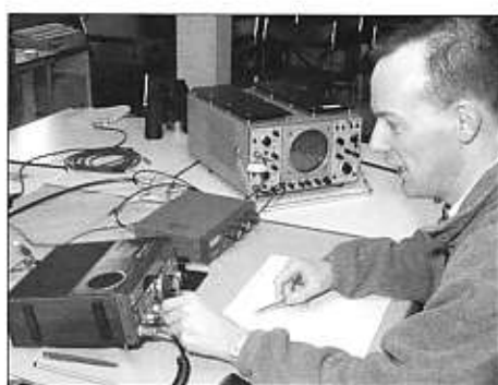
Coen, PA5KM achter de HF-set van PI53ZLD met naast hem een scope om de modulatie diepte op kanaal 3700 te controleren.
