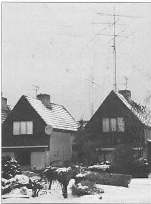
De mast die Henk heeft gemaakt met de antennes achter ons huis. Iets minder goed te zien is een tweede kleine mast tegen de achterkant van het huis en nog wat losse antennes her en der tegen de zijgevel. Het "geluid" van P14WBR komt hier regelmatig vandaan.
