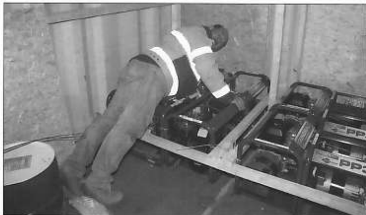
Rob, PA2R, bezig met het vastzetten van de 9 stuks generatoren. Zouden ze gaan schuiven tijdens de tocht naar de andere kant van de aardbol dan zou dat een ravage aan kunnen richten.
