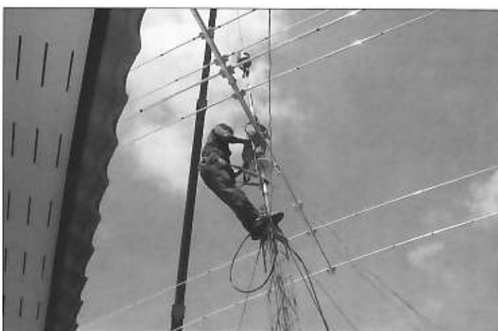
Fred V85AF, bezig met de C3 vast te zetten in top van de mast.
