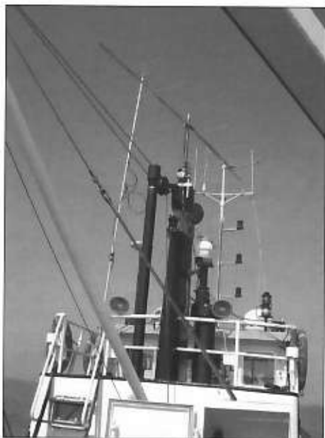
De antenne-installatie van PA1TK aan boord van MV "Welsing".
