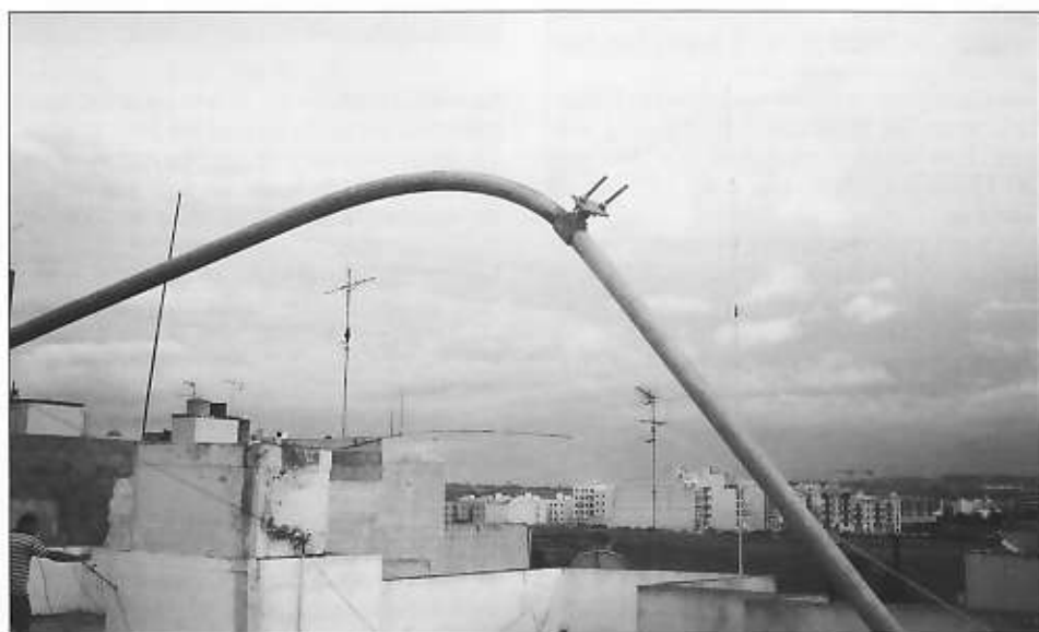
Zo kan een antennemast er uitzien na een storm.
