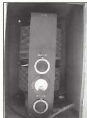
De tuningsbox uit de oude LW zender, voor het verwijderen van het zand uit de box.
