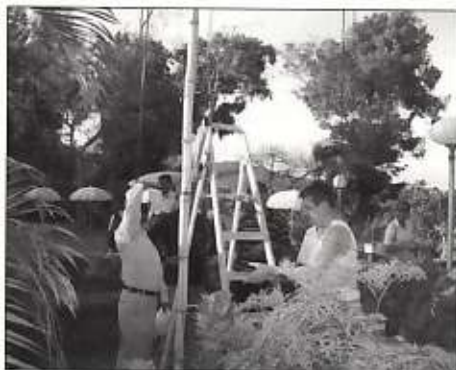
Opbouwwerkzaamheden van de EME antenne-installatie.
