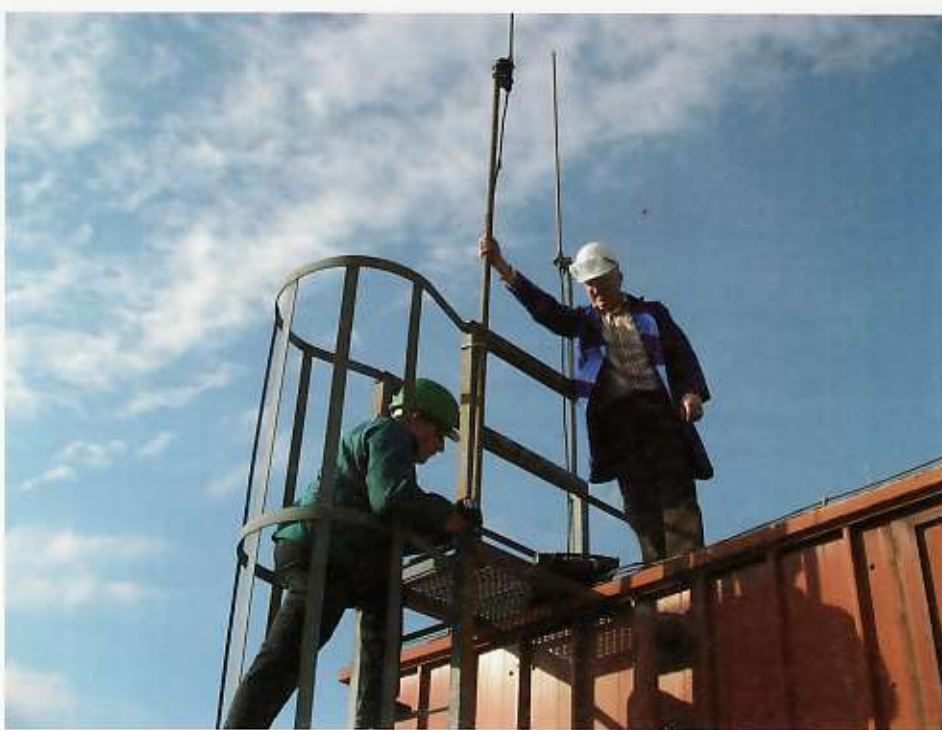
Demontage van de antennes; bovenaan Henk, PEOSSB, onderaan Cor, PAoGTB
