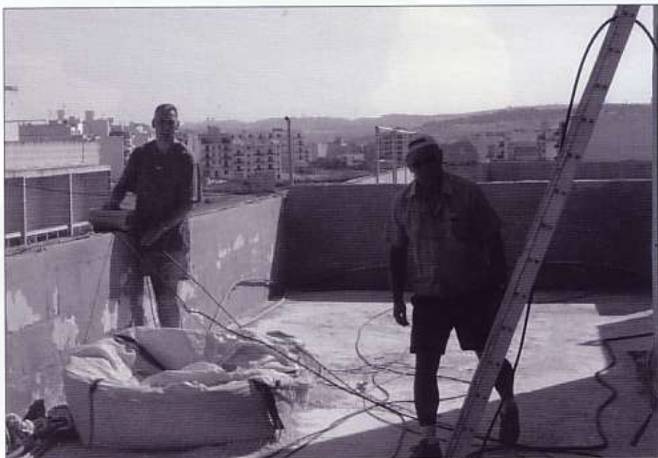
De opbouw van de antennes vond plaats tussen het bouw materiaal.
