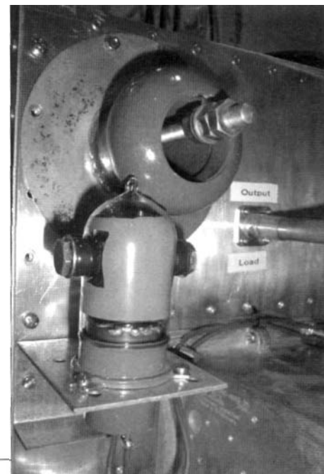
Vacuüm-relais tot 5kV. Controleer wel even of hij nog vacuüm is voordat je hem gebruikt!
