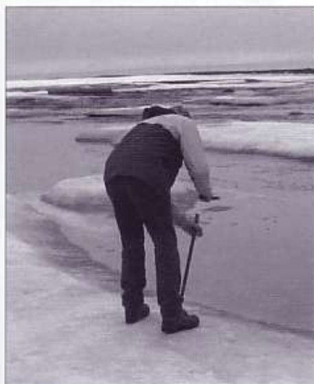
Even een paaltje in het ijs slaan voor de tuidraden.
