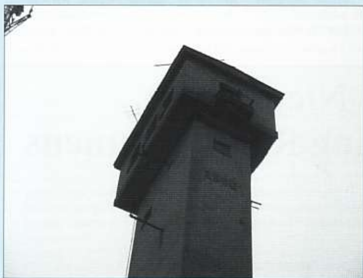
Het station LY2WR/2 heeft zijn onderdak gevonden in een 40 meter hoge, gemetselde, oude telecommunicatietoren.
