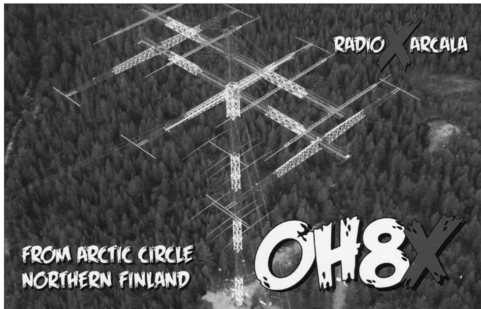
Een antenne-installatie, waarvan de meesten van ons niet eens durven te dromen: van boven naar onder: 4 el voor 80, 3 el voor 160 meter en daaronder 4 x 4 voor 40 meter. Het hoogste punt van de toren is 100 meter boven de grond.
