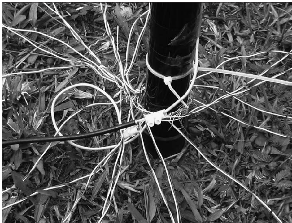
Aardnet van een vertical, met de straler aangesloten op de coaxkabel met behulp van kroonsteentjes.
