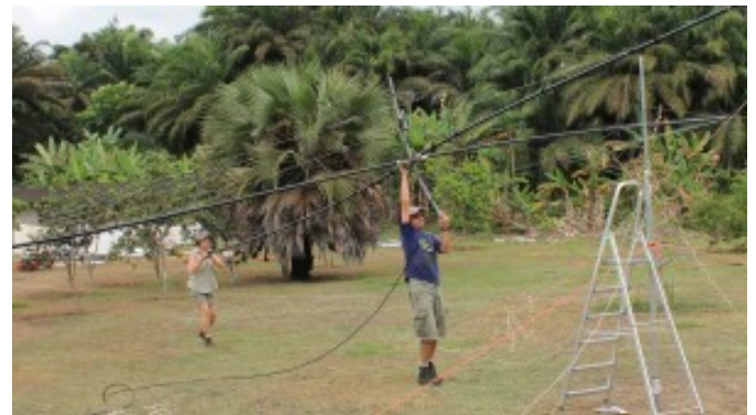
Marian en Ad plaatsen een van de beams op een uitschuifmast
