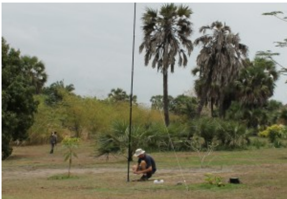
Arie sluit de radialen aan op de 40m vertical
