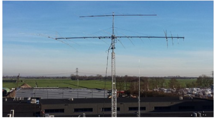
Een deel van het antennepark van de Radio Club Bunschoten, de 17 el. Optibeam voor 40, 20, 15 en 10 meter en de 6el. 6 meter beam
