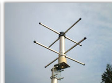
Figuur 5, Turnstile antenne.
