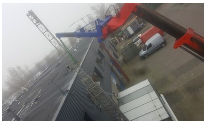
Het topdeel van de mast werd begin december uit de overige delen van de mast gehesen.
