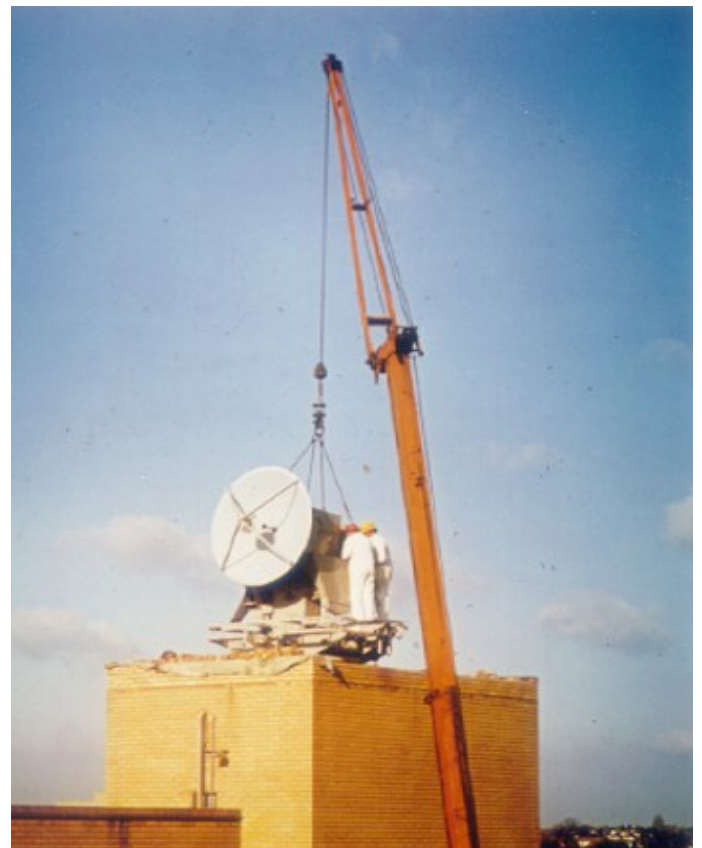
De eerste satellietantenne wordt op zijn plaats gehesen op de top van het BB-gebouw van de Universiteit van Surrey
