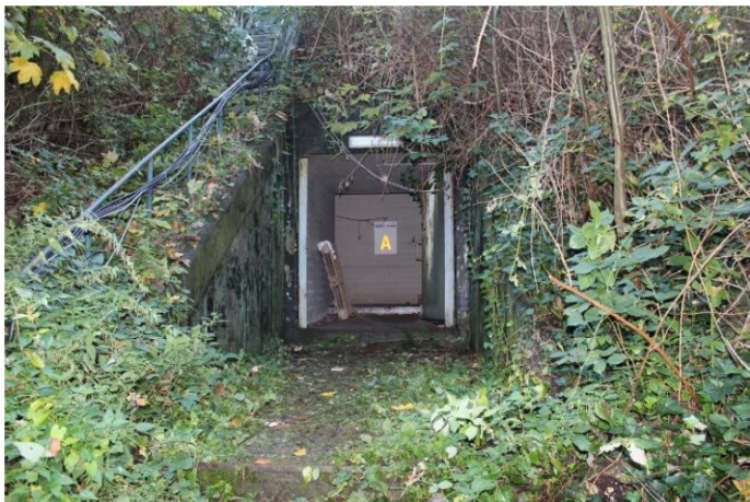
Verborgen in het struikgewas de toegang met 5 deuren
