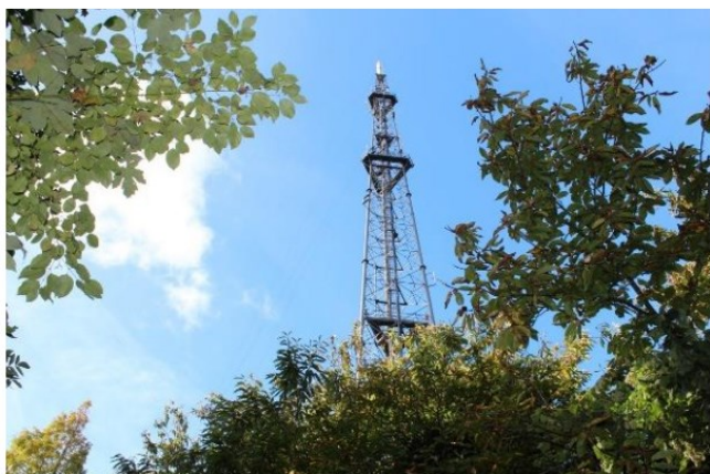
Vanuit de bunker, de mast met omlopen op 65 en 105 m
