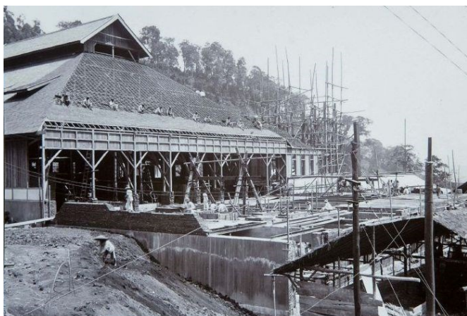
Foto: Bouw Radiostation Malabar
